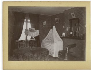
Une chambre à coucher d'un logement au troisième étage de l'aile droite du Palais social
