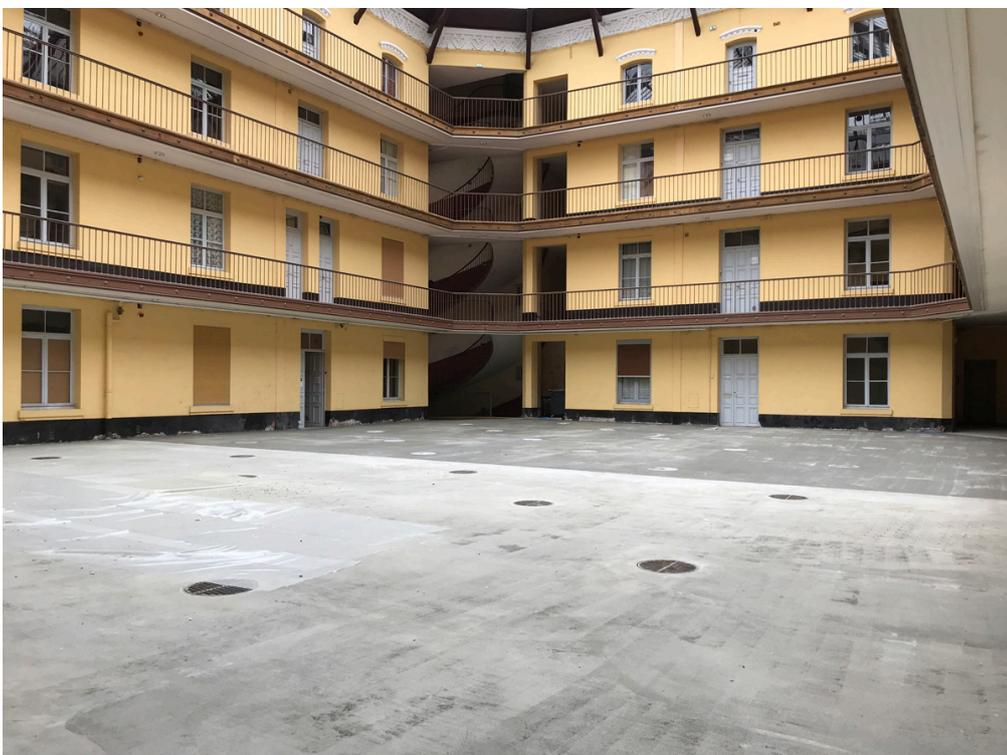
La cour de l'aile droite le 1er juillet 2020 : séchage de la nouvelle dalle.
