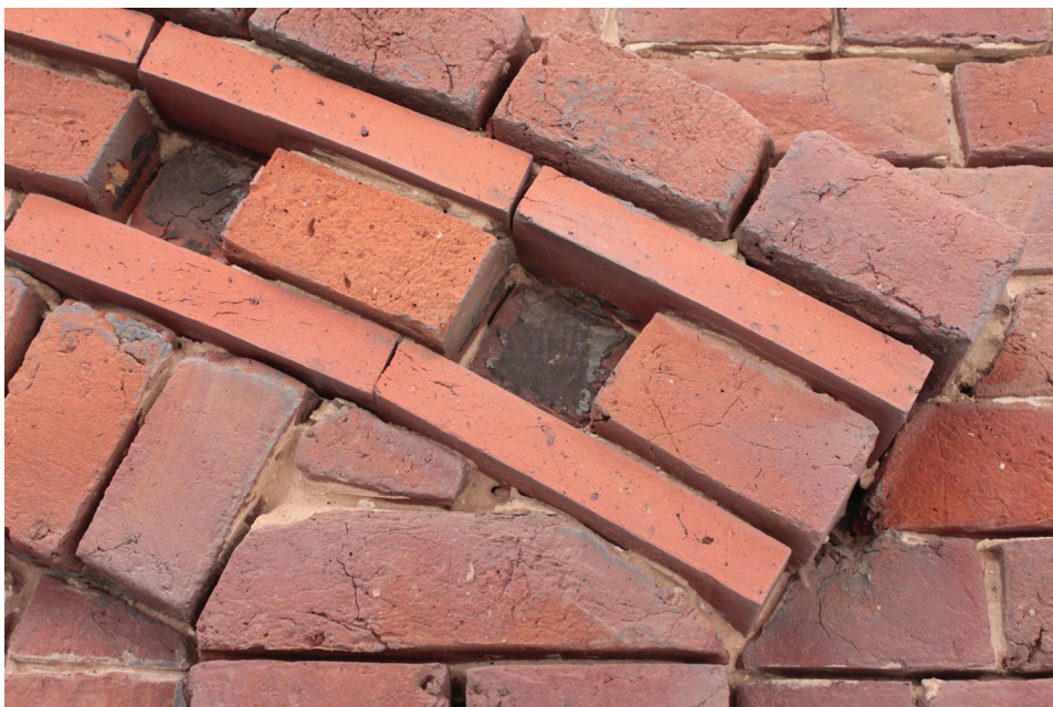
Briques en creux d'un fronton de fenêtre de la façade sud du pavillon central assombries au noir de fumée
