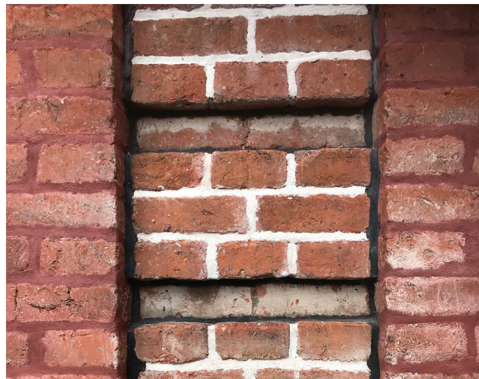
Appareil de briques boutisses et panneresses avec jointoiment polychrome d'un pilastre de la façade sud du pavillon central après restauration.
