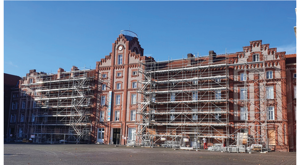
Échafaudage des parties à restaurer de la façade sud du pavillon central.
