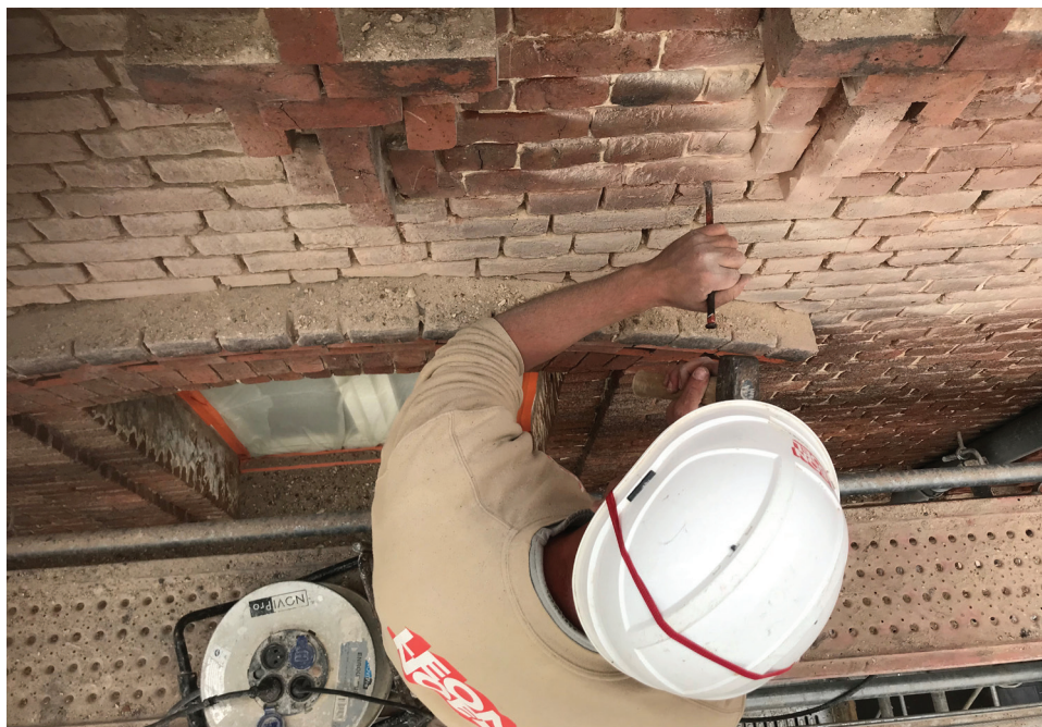
Dégarnissage des joints de maçonnerie sur la façade du pavillon central, novembre 2022
